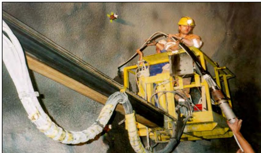
**Figura arriba:** Montaje vertical y horizontal del extensómetro en un túnel
